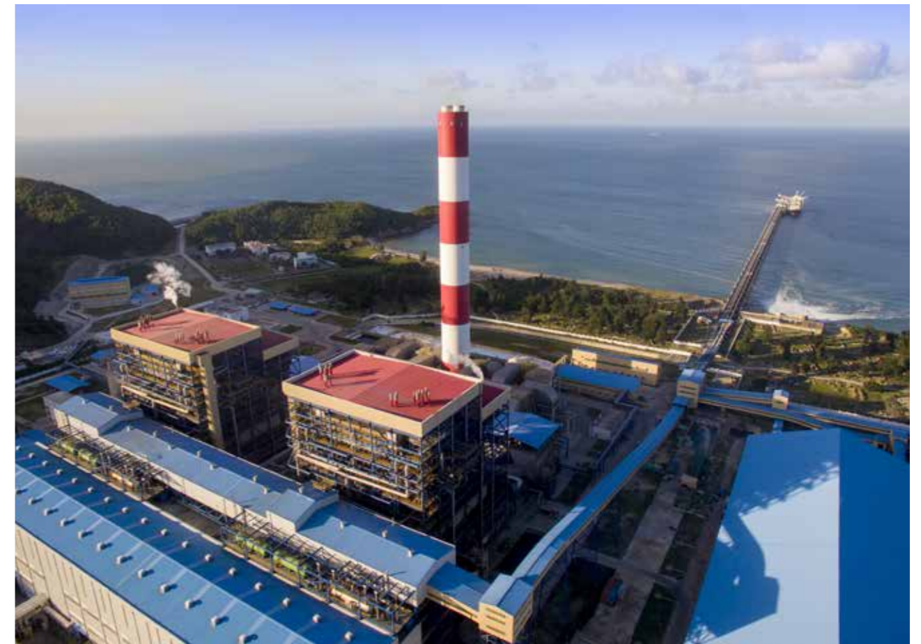
PV Power Vũng Áng
