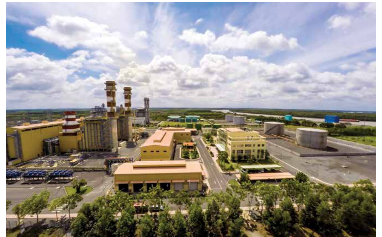
PV Power Nhơn Trạch
